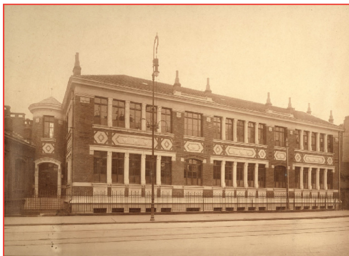
Figure 5 - Le bâtiment inauguré en 1928.
