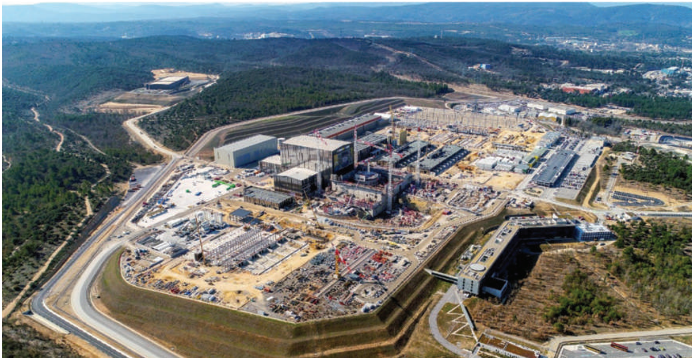
Figure 1 - Vue aérienne du chantier ITER à Cadarache en avril 2018 (© ITER Organization). Le site a une superficie totale de 181 hectares. À droite, le siège de l'Organisation internationale ITER (bâtiment avec angle). Le réacteur se trouvera dans le silo en béton de forme cylindrique, situé à droite du plus haut bâtiment sur la plateforme (bâtiment d'assemblage). Sur la colline à gauche, une zone de stockage. Plus de trois mille personnes travaillent actuellement sur le site.
