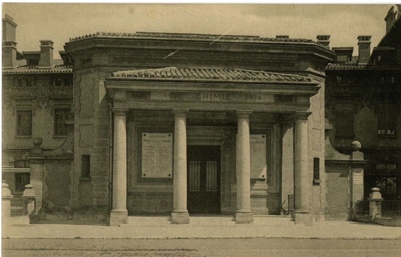
Figure 2 - Pavillon de l'amphithéâtre de l'Institut de chimie. Au premier plan, l'amphithéâtre de chimie avec son architecture de style classique. En arrière-plan, le corps du bâtiment de l'Institut dont les façades sont ornées de décors de sgraffites. Source : Carte postale Arecole Marque déposée. 11, Q. de Versailles, Nantes. Faculté des Sciences. 42. Amphithéâtre de chimie.
