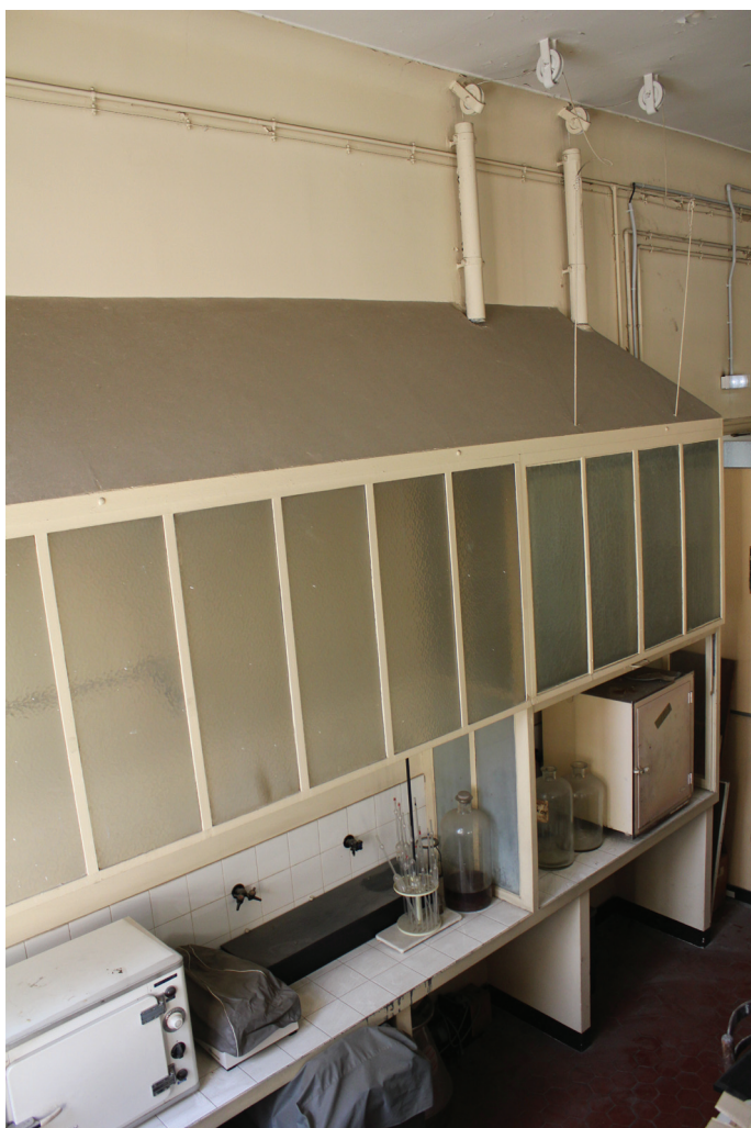
Figure 7 - Vue générale de la dernière hotte en place. Conservée au premier étage de l'Institut de chimie au sein de la salle de TP 1, cette hotte possède encore le mécanisme de poulies permettant d'ouvrir et d'en fermer une partie (© B. Vila).
