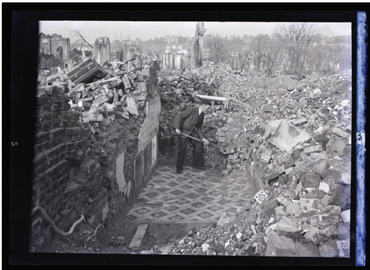
Figure 2 - Le Havre, déblaiement après les bombardements de la Seconde Guerre mondiale. © Galica.bnf.fr/Bibliothèque municipale du Havre.
