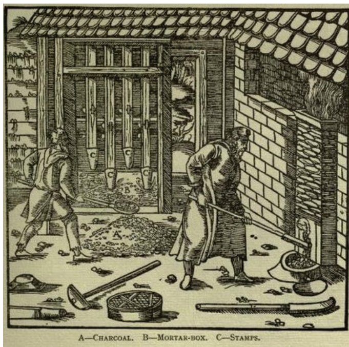
Figure 5 - Un atelier de préparation du fer au Moyen Âge (figure extraite de [12]).
