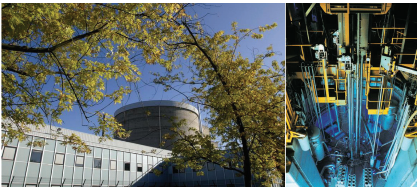
Figure 2 - Le réacteur Orphée à Saclay (à gauche) et son cœur entouré par une piscine d'eau (à droite). Orphée a divergé en 1980 et, en lien avec le Laboratoire Léon Brillouin (LLB, CEA-CNRS), constituait la source nationale française jusqu'en 2019. © LLB.
