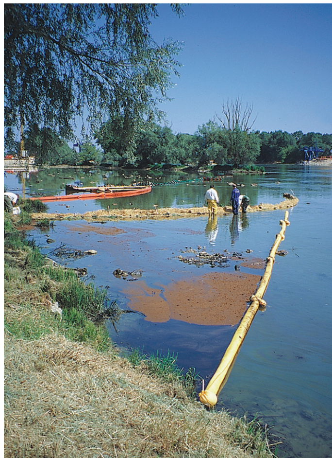
Confinement d'hydrocarbure par barrage flottant, barrage de paille et barrage absorbant. © Cedre.
