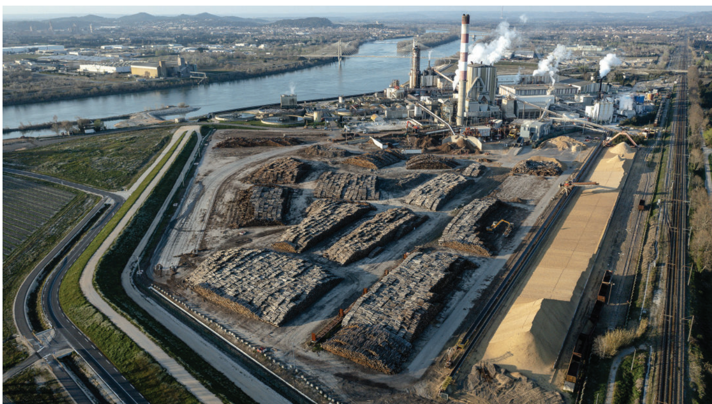
Usine de pâte à papier de Fibre Excellence située à Tarascon (© Fibre Excellence).
