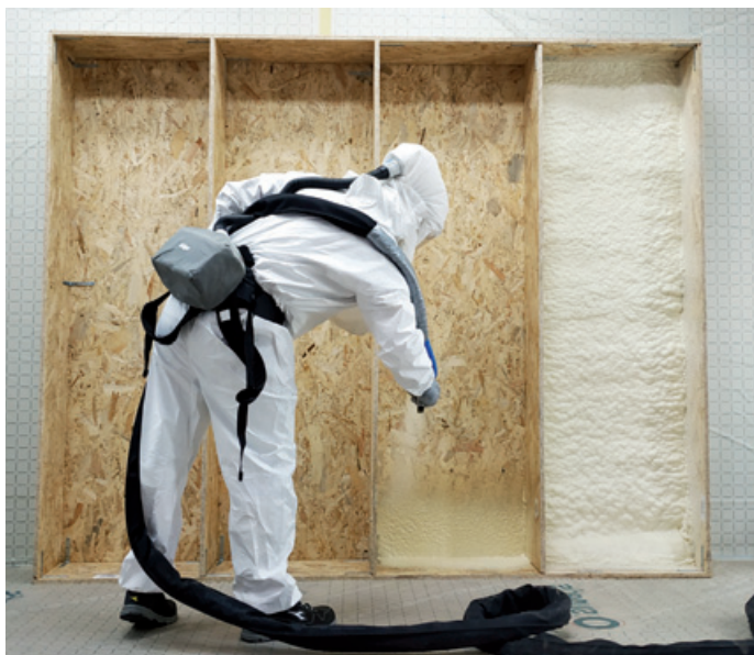
Projection du polyuréthane. © M.-T. Dinh-Audouin.
