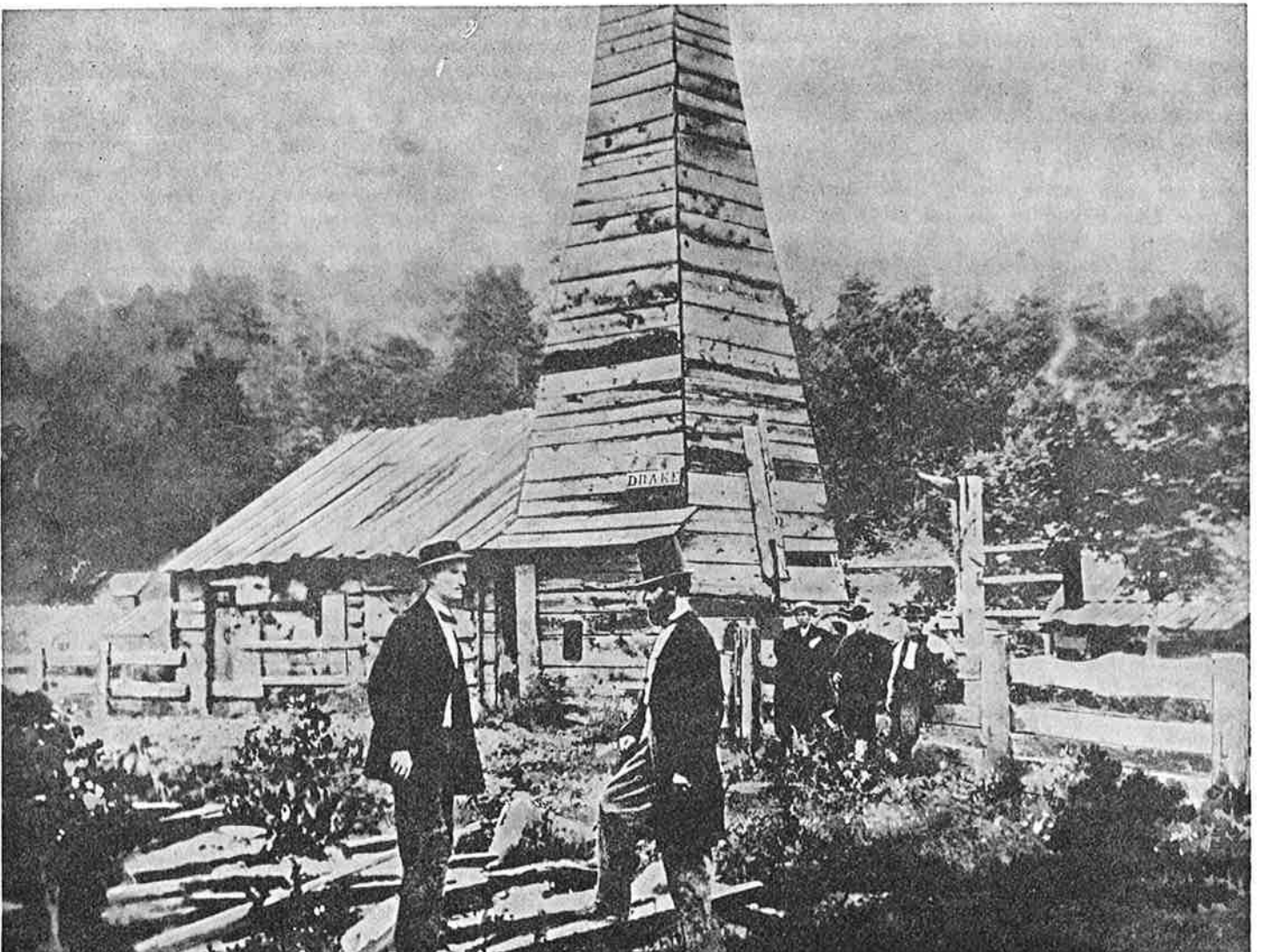
Inspirées des méthodes chinoises, les premières techniques de forage furent rapidement perfectionnées. Le premier puits de Edwin L. Drake (portant un chapeau haut-de-forme sur la photo), foré à Titusville (Pennsylvanie) en bordure de la rivière « Oil Creek », atteignit le pétrole le 28 août 1859, à la profondeur de ... 69 pieds et demi. Il débitait 35 barils par jour soit environ 5 600 litres ( Photo Usis ).
