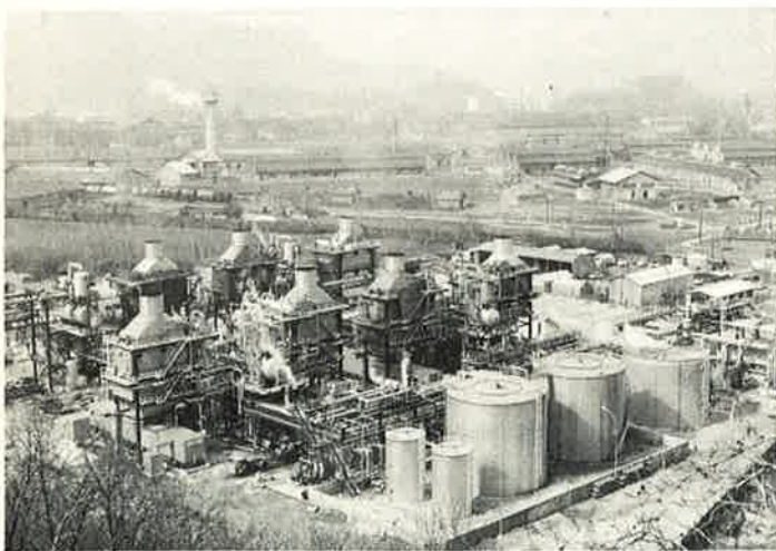
Centrale thermique de Pont-de-Claix. (Photo Progil).
