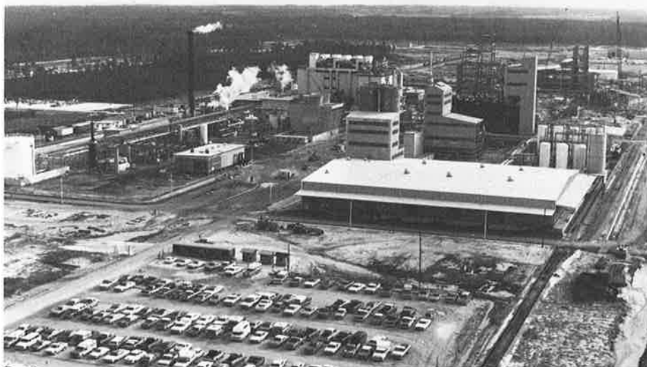
Degussa Alabama Inc. : Vue d'ensemble des installations de la première et de la deuxième tranche d'extension. A gauche, le complexe énergétique et, à l'arrière plan, l'usine de production de méthionine. A droite, en avant, le hall de stockage d'Aerosil® et, en arrière, les usines de production d'Aerosil et de tétrachlorure de silicium. On aperçoit à l'arrière-plan, à droite, les carcasses d'acier des usines de la deuxième tranche d'extension (chlorure de cyanuryle et acide cyanhydrique) qui doivent entrer en service en 1978.
