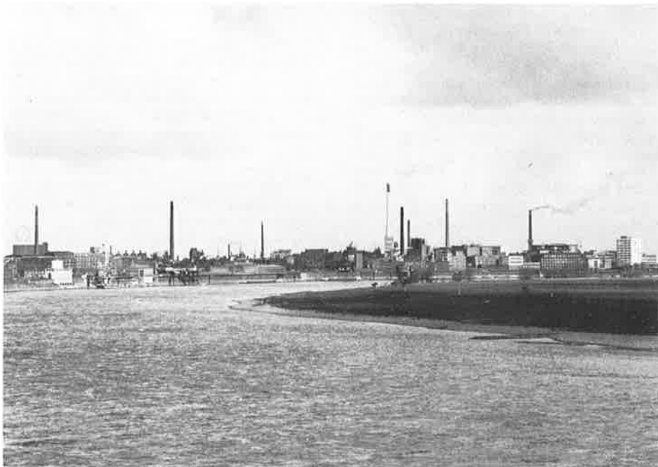
Vue d'ensemble de l'usine Bayer d'Uerdingen
