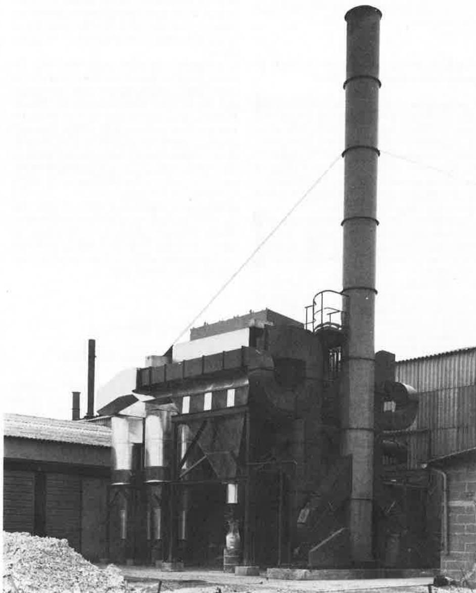
attention toute particulière aux problèmes de maintenance de l'unité de filtration. Dans les filtres utilisés, les manches ont été remplacés par des cassettes filtrantes peu encombrantes et facilement accessibles par la face latérale du filtre. Cette technique évite d'avoir à pénétrer dans le filtre en cas d'entretien ou de changement du média filtrant. Toutes les interventions se font à l'extérieur du filtre sans danger pour le personnel.
