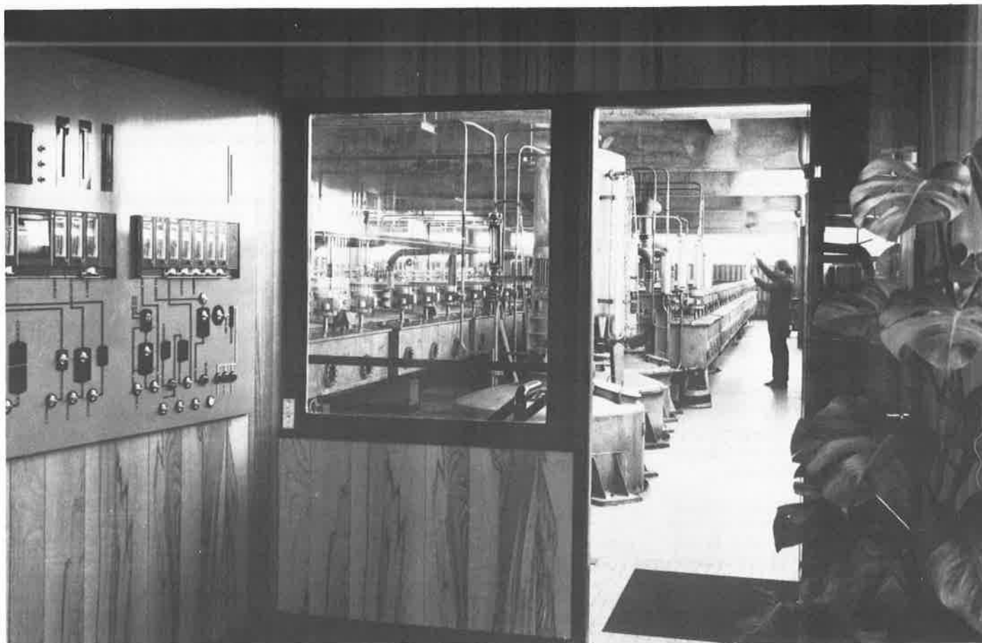
Atelier de séparation des Terres rares (extraction par solvant) de l'usine Rhône-Poulenc de La Rochelle.
