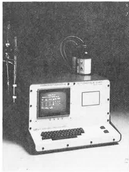
Cet ensemble compact permet, sans surveillance, la mise au point automatique des analyses grâce à sa programmation de la composition du solvant, du débit, des sécurités haute et basse de pression, des injections, de la longueur d'onde et la compensation de la dérive de la ligne de base du spectrophotomètre.
