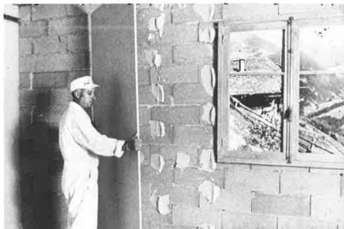
Pose de plaques de plâtre-isolant.
