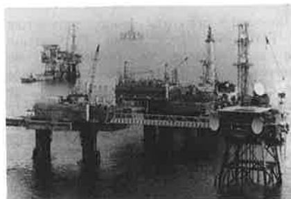
Les installations du champ gazier de Frigg, l'une des plus importantes réalisations marines du groupe.
