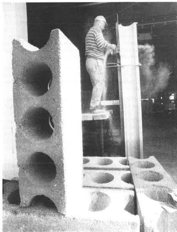
FIGURE 3. - Eléments de mur en béton-PS expansé. Leur découpe sur chantier est aisée. Les vides sont ferrillés et remplis de béton pour assurer la solidité des éléments porteurs.
