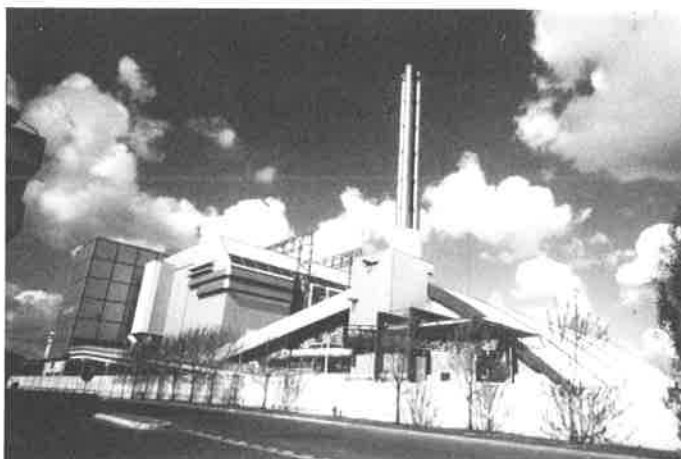
FIGURE 5. - La nouvelle usine de Saint-Ouen incinère 1,6 Mt/an d'ordures ménagères.
