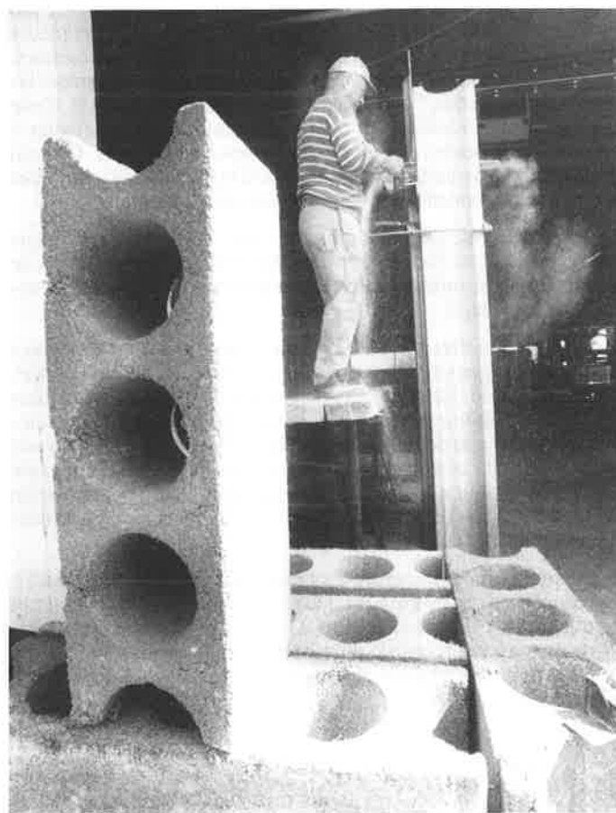
FIGURE 3. - Eléments de mur en béton-PS expansé. Leur découpe sur chantier est aisée. Les vides sont ferrailés et remplis de béton pour assurer la solidité des éléments porteurs.
