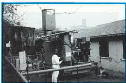
Plate-forme de venting sur départ réseau dépollution.
