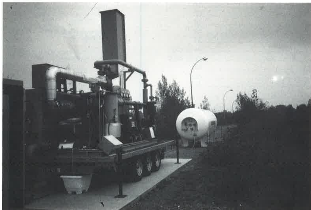
Décontamination d'un site pollué par la société Valtech
