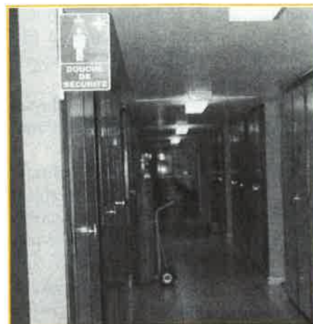
B. Faucher : " La douche de sécurité est située dans un local où il est possible d'allonger l'accidenté si nécessaire et de le déshabiller en toute discrétion".
