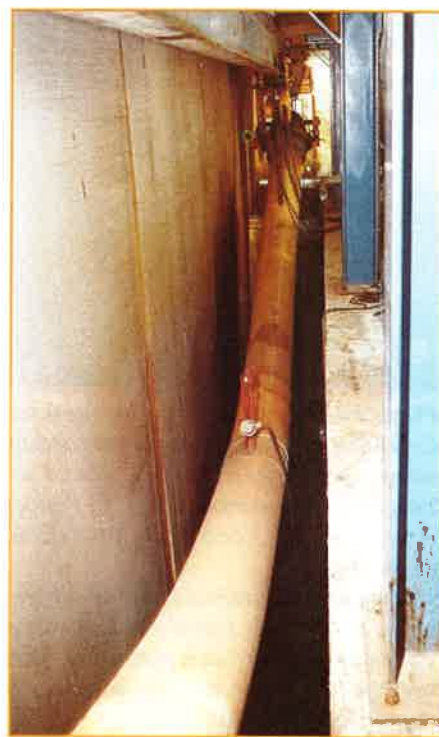
Photo 1 - Banc d'essai de flexibles de production - Installation extérieure pour des essais de longue durée en conditions réelles d'un flexible prototype de 12 m de long et de 10,56 cm (4 pouces) de diamètre.
