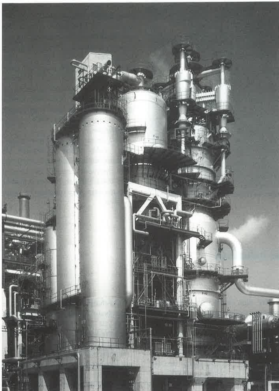
Photo 1 - Première unité de craquage catalytique de résidu fonctionnant selon le procédé R2R pour la société Idemitsu, à Aïchi au Japon (photothèque IFP).
