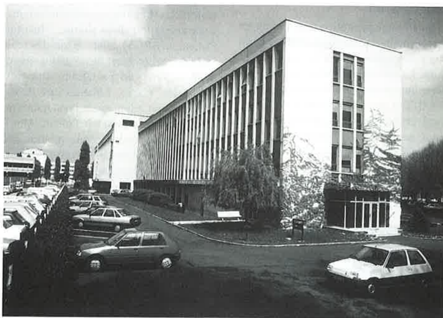
Photo1 - L'Institut de Recherches sur la Catalyse à Villeurbanne (vue partielle).
