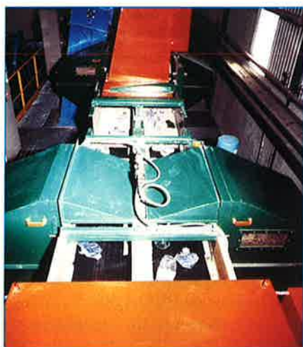
Photo 6 - Installation expérimentale de tri complémentaire (photo Solvay chez Micronyl).
