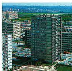
Réseaux de chauffage urbain
