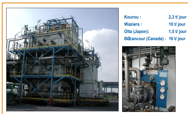
Figure 5 - Boîte froide de liquéfaction de l'hydrogène à Waziers et turbine de détente de l'hydrogène conçue à la division des Technologies Avancées d'Air Liquide.
