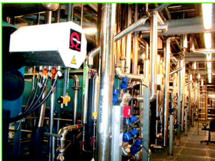
Figure 3 - Groupe de froid du lyophiliseur du site MSD de Mirabel.
