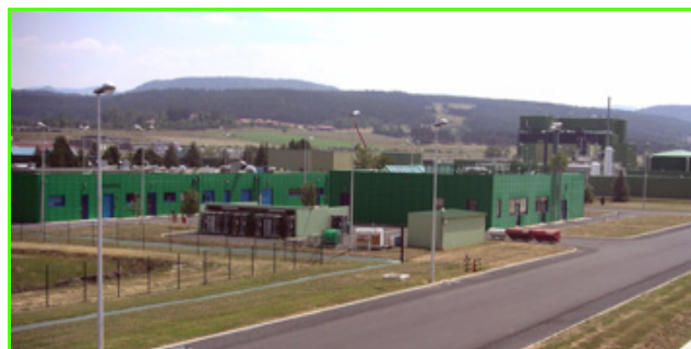
Une usine chimique à la campagne.
