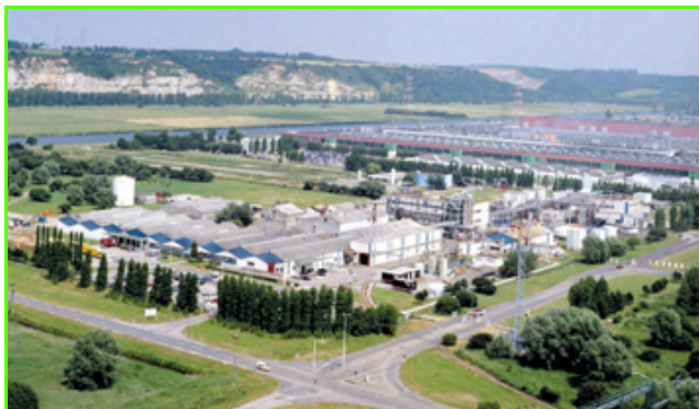
L'usine de production du Havre. Photo : Eliokem DR.
