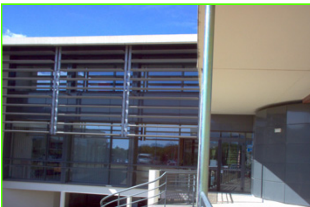
Figure 4 - Palumed : deux laboratoires de 100 m 2 et 50 m 2 de locaux administratifs à Prologue-Biotech, en bordure de Toulouse (photographie : L. Joumel).
