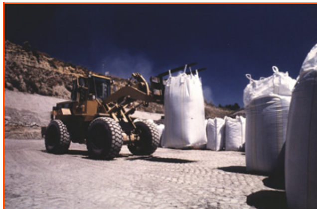
Figure 1 - Gravats de démantèlement (déchets TFA). © Andra.
