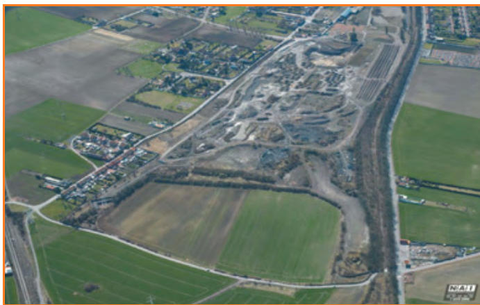
Figure 4 - Réhabilitation du site industriel de Vendin.
