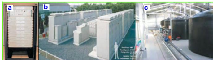
Figure 5 - (a) : Exemple de système de stockage lithium-ion envisagé pour l'habitat solaire connecté au réseau ; (b) : Batteries sodium-soufre ; (c) : Batteries redox à circulation d'électrolyte.
