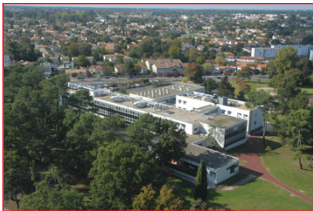
Figure 1 - Le Centre de Recherche Paul Pascal à Bordeaux (CRPP).
