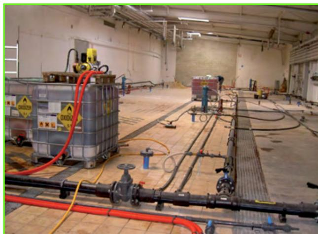
Figure 13 - Procédé de traitement d'une nappe polluée par des hydrocarbures sous un bâtiment par injection de permanganate de sodium.
