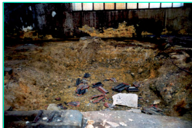
Figure 1 - Les déchets de chrome de cet atelier de traitement de surface ont même détérioré le mur ! On imagine les répercussions sur la santé du personnel... Photo : P. Pichat.
