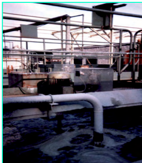
Figure 6 - Cuve de neutralisation d'un déchet acide. Photo P. Pichat.
