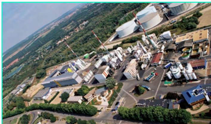
Figure 11 - Centre de valorisation et de traitement de 200 000 t/an de déchets toxiques et dangereux (Yvelines).
