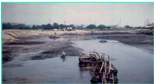
Figure 5 - « Stockage » d'un déchet dans une lagune, sans doute avec l'espérance d'une évaporation rapide, voire d'une infiltration dans le sous-sol... Photo P. Pichat.
