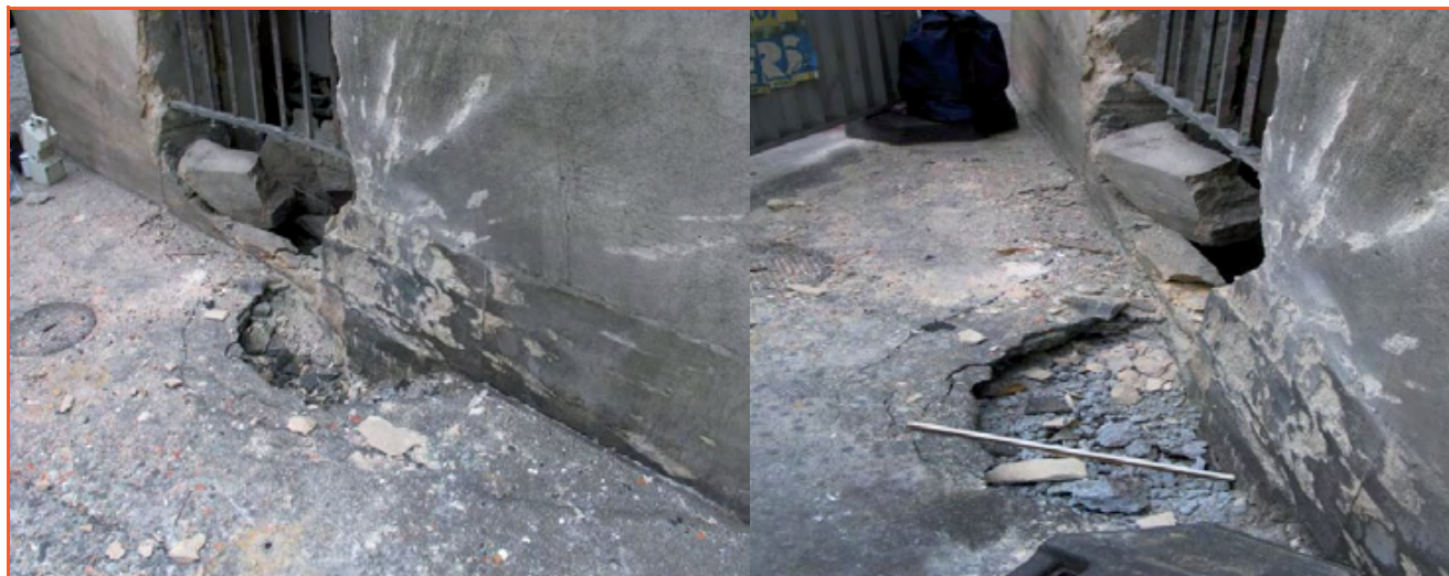
Figure 1 - Vues du cratère après explosion (dimensions du cratère : 96 x 41 x 30 cm).
