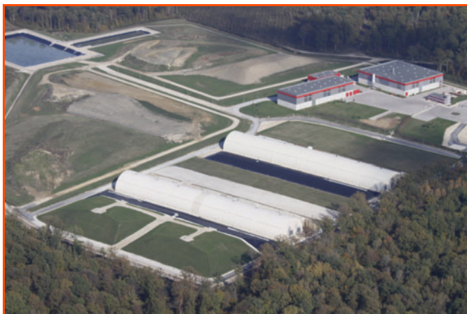
Figure 2 - Vue aérienne des alvéoles du centre de stockage TFA de Morvilliers. © Andra/P. Bourguignon.
