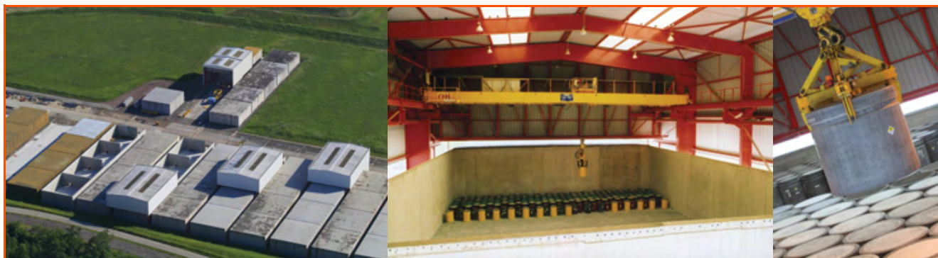
Figure 3 - Le centre de stockage des déchets radioactifs de faible et moyenne activité. © Andra.
