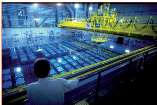
Figure 8 - Piscine d'entreposage des combustibles usés. Usine de traitement des combustibles usés AREVA, établissement de La Hague, Cherbourg. © AREVA/LESAGE Philippe.
