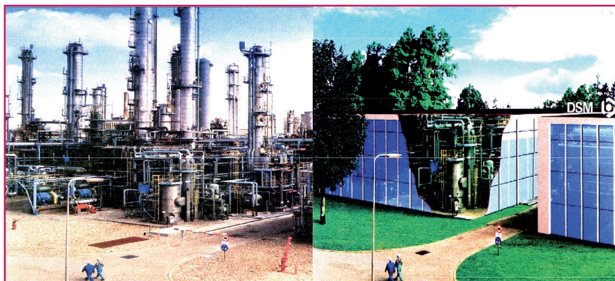
Figure 5 - Vision de l'usine du futur utilisant les technologies d'intensification des procédés (à droite), à comparer avec une usine actuelle (à gauche) : une économie de 30 % en matières premières, énergies et coûts opératoires. Courtesy of DSM.
