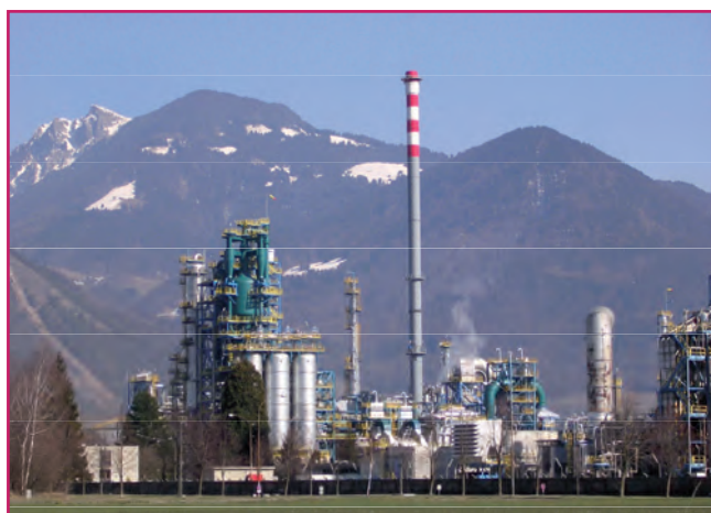
Figure 6 - Unité de craquage catalytique en lit fluidisé de production d'essence à partir de coupes pétrolières lourdes (raffinerie Tamoil, Collombey, Suisse). Courtesy of Axens-IFP Energies nouvelles.
