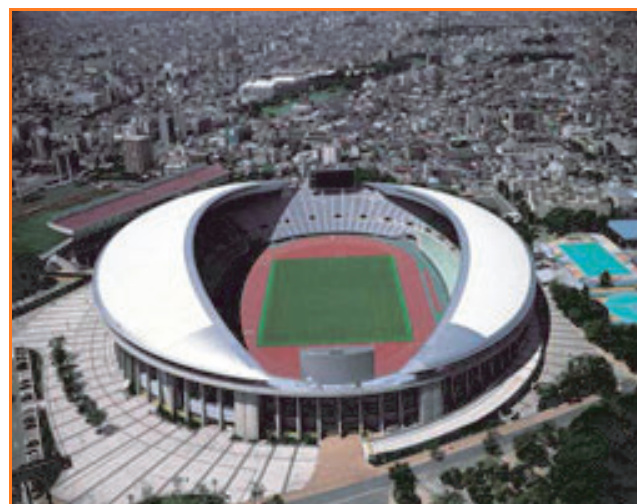
Figure 4 - Couverture du Nagai Stadium à Osaka avec des textiles photocatalytiques de la firme Taiyo Kogyo Corp.
