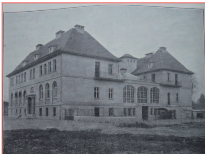
FIG. 14. — L'ÉCOLE NATIONALE SUPÉRIEURE DU PÉTROLE ET DES COMBUSTIBLES LIQUIDES
