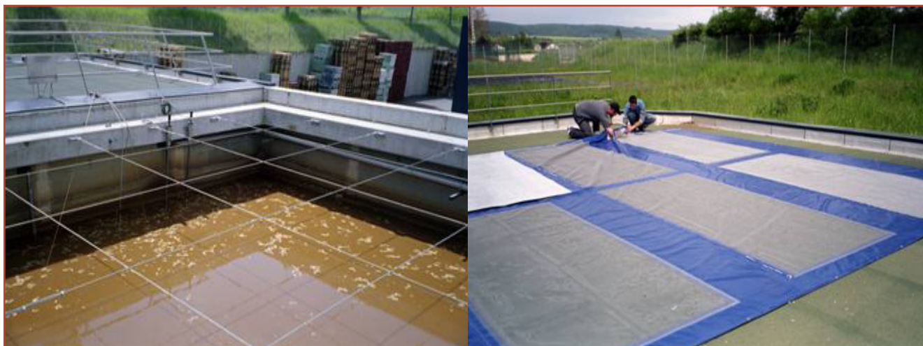
Figure 5 - Pose d'une bâche de papier Ahlstrom® avec dépôt de \text{TiO}_2 associé à du charbon actif, tendue au-dessus du bassin biologique d'une moutarderie de Bourgogne pour l'élimination photocatalytique solaire des odeurs émises par le traitement biologique. À gauche : bassin et cadre de support. À droite : bassin recouvert de la bâche.
