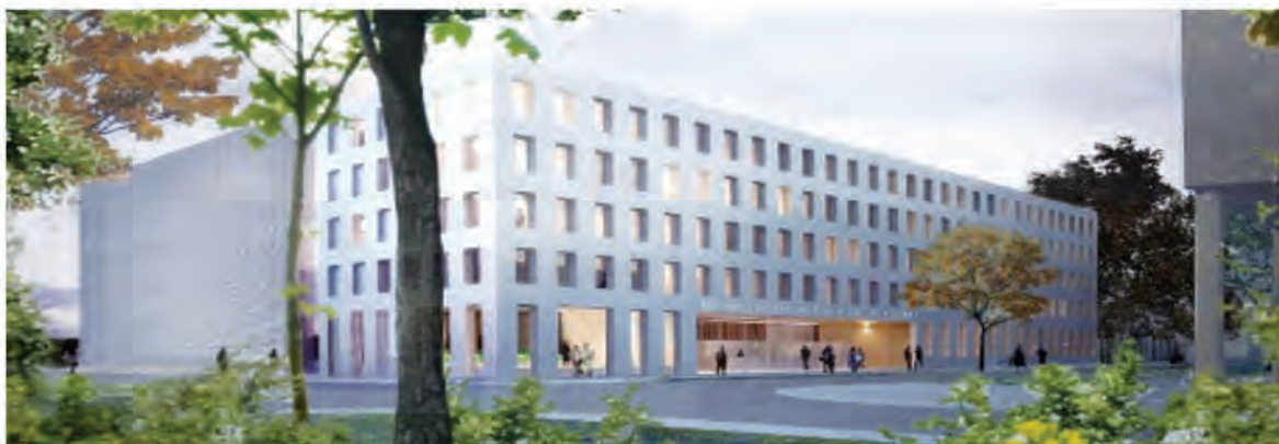
Perspective du bâtiment de l'IPVF, qui devrait être livré la mi-2017 (crédit Pargade Architecte)
