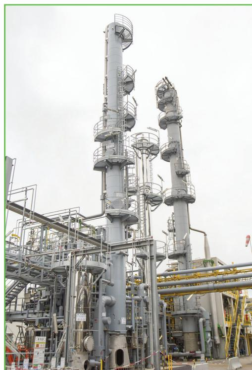
Unité de production d'acétate d'isopropyle utilisant une distillation réactive. © Novapex.
